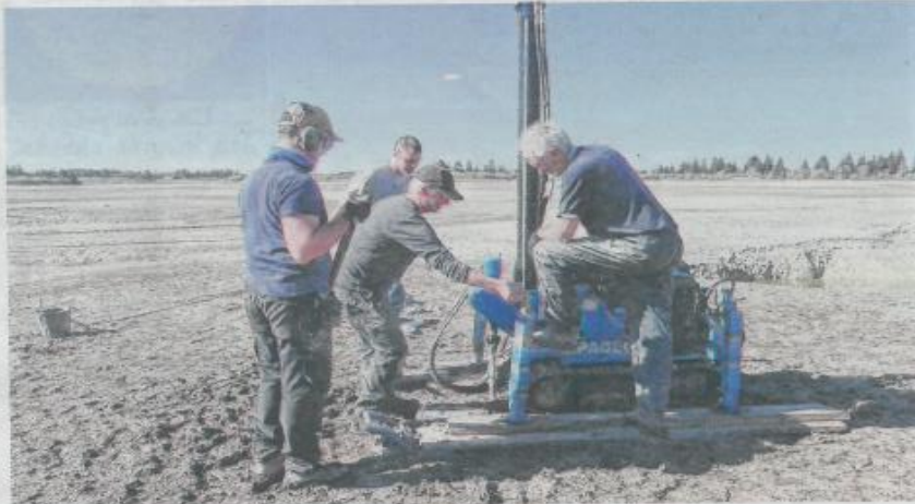
La machine nécessaire au carottage ne pèse pas loin d'une tonne.
