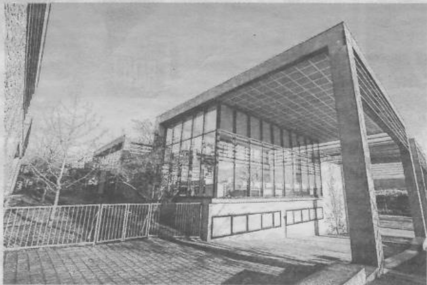
L'Université a lancé des travaux de rénovation. Photo Daniel WAMBACH
